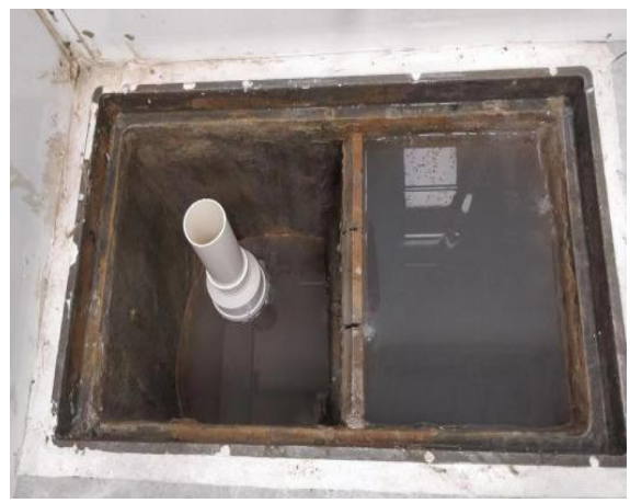
图 2 美容废水消毒池内设过滤网 (TW002)
