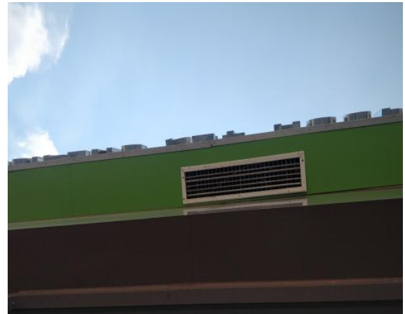
图 4 总排气口朝向马路一侧
