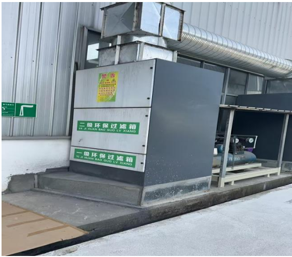
漆房废气处理装置
