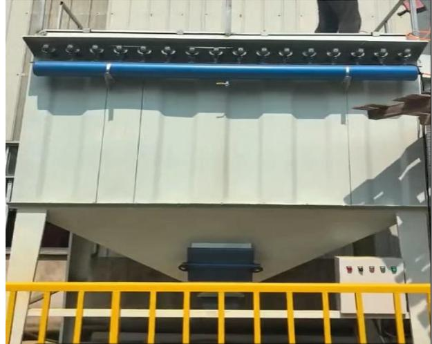
图 3-4 废气处理设施(袋式除尘器)
