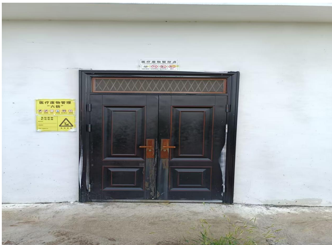
图 4-6 危废（医废）暂存间
