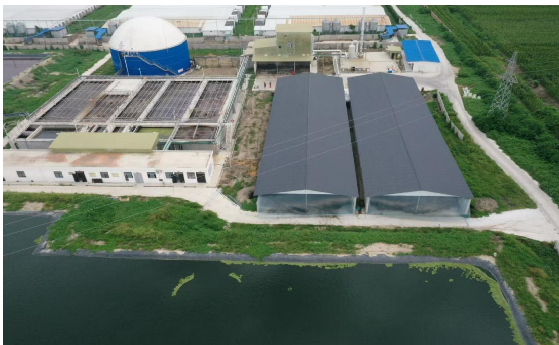
图 4-1 污水处理站全景图
