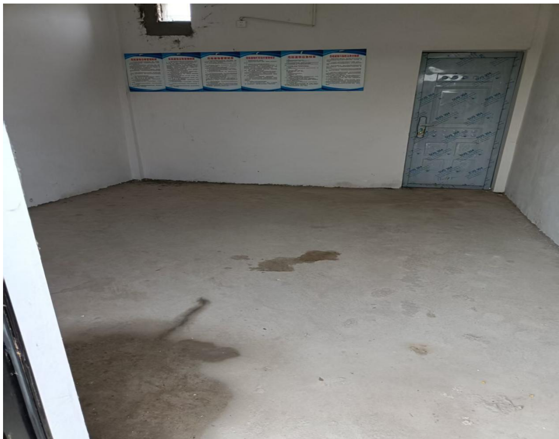
图4-7 危废暂存间内部
